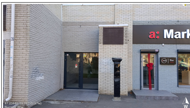
Фото объекта П13610063706 Ростовская область, г. Ростов-на-Дону, пер. Семашко, 113, ком.1,2,3,4,5, нежилое помещение №3 Геокоординаты: 47.2343994 39.7071528 Дата: 30.01.2026 Имя файла: 254°_80м_47.23440, 39.70715 (±7м)_25122025_135530.jpg
