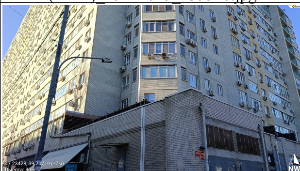
Фото объекта П13610063706 Ростовская область, г. Ростов-на-Дону, пер. Семашко, 113, ком.1,2,3,4,5, нежилое помещение №3 Геокоординаты: 47.2342765 39.7071892 Дата: 30.01.2026 Имя файла: 304°_80м_47.23428, 39.70719 (±7м)_25122025_135555.jpg
